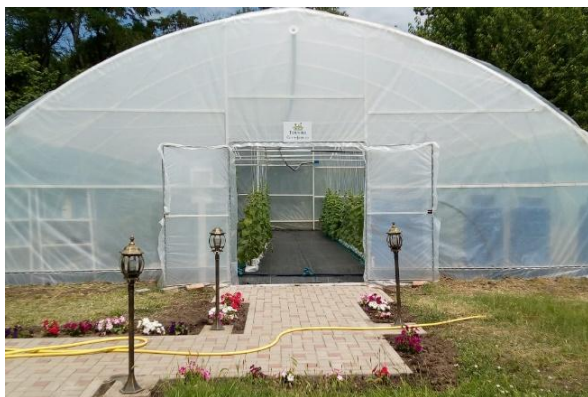
Рисунок 19 - Теплица на гидропонной системе, площадью 140 квадратных метров на территории ГБУ ДО КК ЭБЦ
